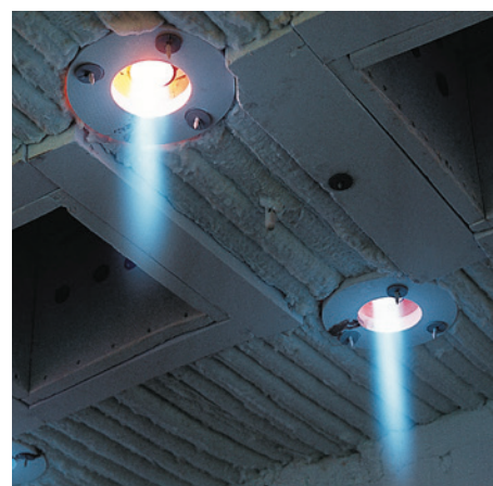
Deckenbefeuerung mit BIC-Brennern
